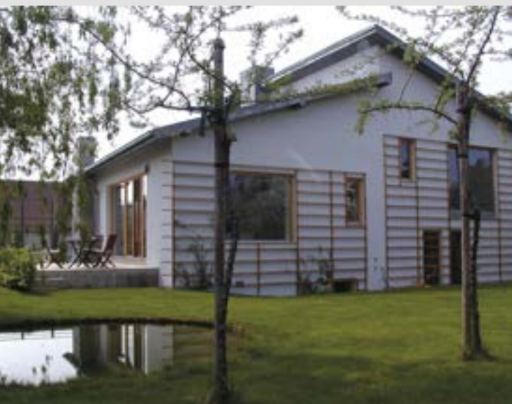
Pohledovou kulisu střízlivé zahrady tvoří subtilní treláž, doprovázející fasádu moderního domu. (Atelier zahradní architektury, Ing. Eva Vízková)
